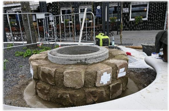
Der Brunnen während des Wiederaufbaus im April 2023.
