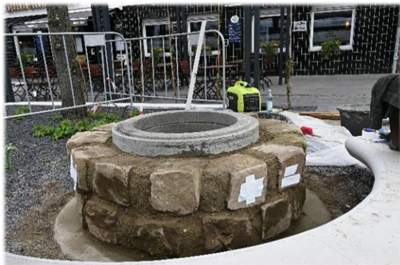
Der Brunnen während des Wiederaufbaus im April 2023.
